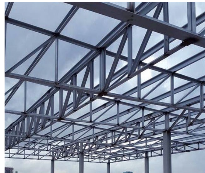
โครงสร้างหลังคา
