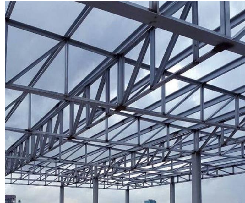
โครงสร้างหลังคา
