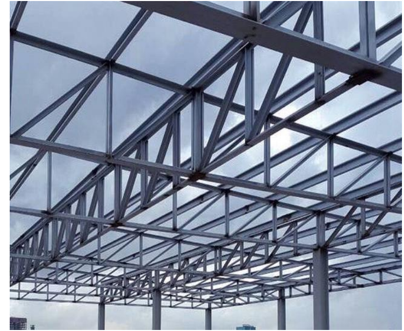
โครงสร้างหลังคา
